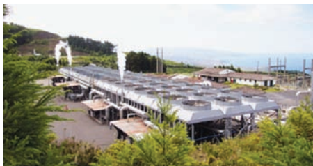
FIGURA 14: Central geotérmica da Ribeira Grande (fonte: SOGEO)
