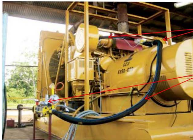
FIGURA 5 - MOTOR CATERPILLAR COM SISTEMA DE FUMIGAÇÃO OU "SINGLE POINT".
