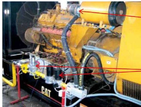
FIGURA 8 - TREM DE GÁS E DIFUSOR EM MOTOR RÁPIDO CATERPILLAR 400 KW.
