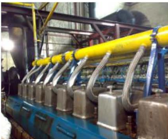
FIGURA 3 - 2 X WARTSILA 9L32, SENDO MOSTRADOS A AMARELO OS COLECTORES COMUNS DE GÁS NATURAL.
