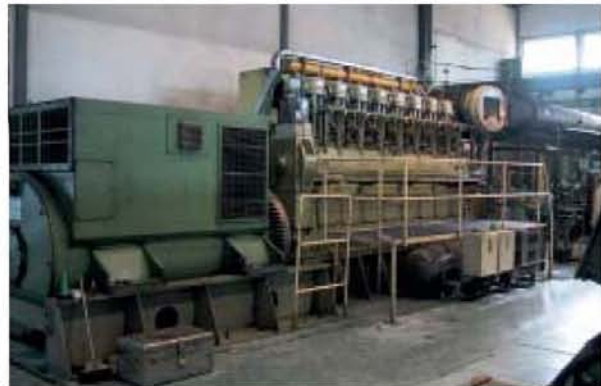
FIGURA 2 - MAK 452C CONVERTIDO PARA OPERAÇÃO DUAL-FUEL .
