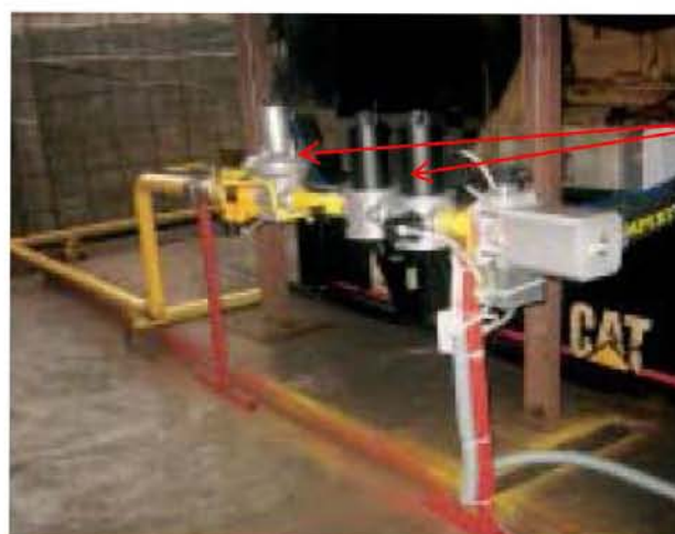
FIGURA 7 - TREM DE GÁS MOTOR RÁPIDO CATERPILLAR 3512 1250 kW.
