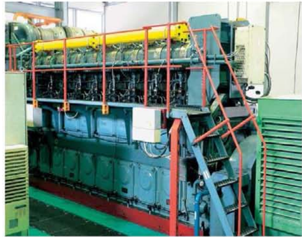
FIGURA 1 - MAN CONVERTIDO PARA OPERAÇÃO DUAL-FUEL 9L32.
