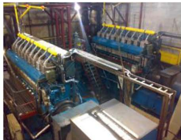
FIGURA 3 - 2 X WARTSILA 9L32, SENDO MOSTRADOS A AMARELO OS COLECTORES COMUNS DE GÁS NATURAL.
