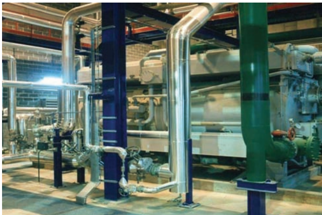
FIG.12 Chiller de absorção de duplo efeito (fonte: Climaespaço)
