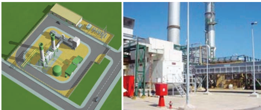
FIG.18 Central de cogeração do Carrico (fonte: PROFICO Ambiente; GALP Energia)
