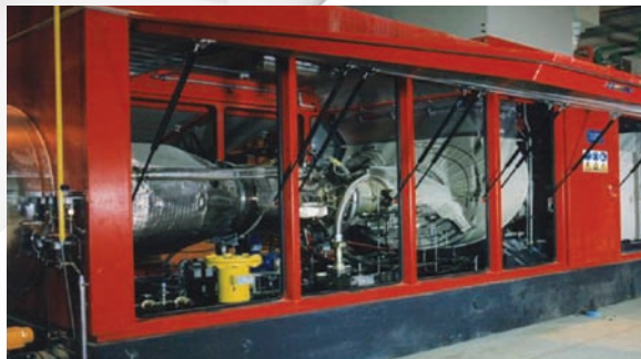
Grupo turbo alternador de unidade de cogeração
